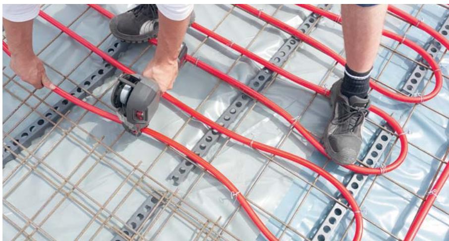
Мокрый монтаж системы тёплого пола Rehau при помощи сетки
