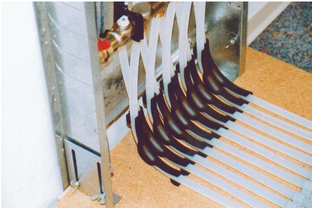
Отвод 90° является отличной направляющей для труб к распределительному коллектору, задает радиус изгиба и предохраняет трубы от механических повреждений о бетон
